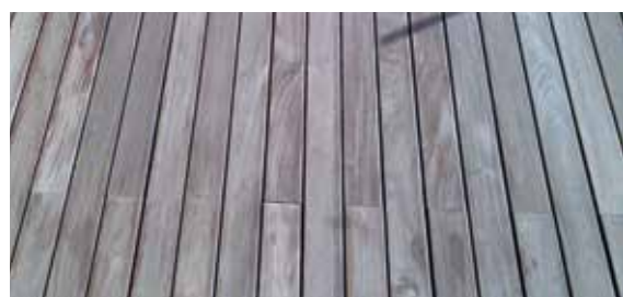
teraszburkolat UV védelem nélkül
